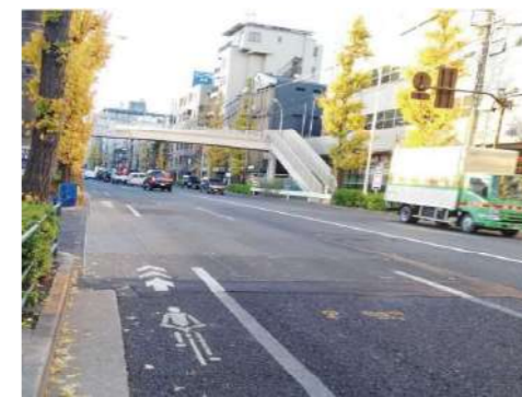
杉並区 青梅街道 都道4号線にて施工 ☆OLY55型 幅5.0m 延長21.0m☆
