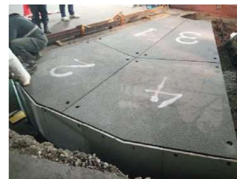
OLY55型 特注製作 OLY+異形覆工板 ☆現場加工が不要なので、曲がり部も最速施工☆
