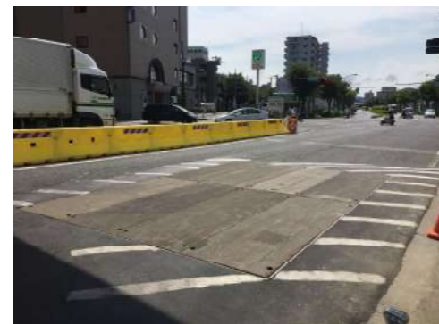
平塚市 国道1号線にて施工 ☆OLY55型 幅4.0m 延長6.0m☆
