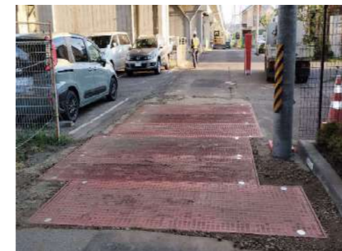
OLY横新型 覆工芯ずらし 電柱回避② ☆現場加工不要で、覆工芯ずらしも最速施工☆
