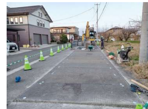
管路160.0m施工の路面覆工を、横型 幅3.0m 延長18.0mを10回転用で施工。 ☆延長の長い路線でも、横型・横新型なら転用もやすく、コスト削減も見込めます。☆
