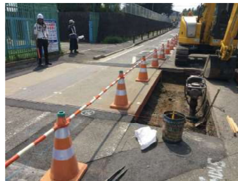
OLY横型・横新型で道路横断 分割施工 ☆横型・横新型なら分割施工も簡単に出来ます☆
