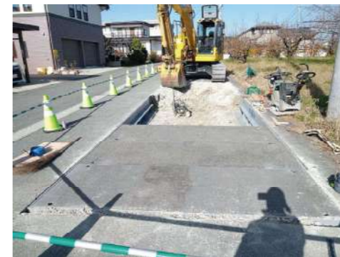
管路160.0m施工の路面覆工を、横型 幅3.0m 延長18.0mを10回転用で施工。 ☆延長の長い路線でも、横型・横新型なら転用もやすく、コスト削減も見込めます。☆
