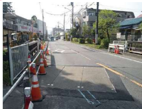
河川橋前後の覆工掛け、二か所同時施工 ☆OLYならスピーディなので、2か所同時施工も可能☆
