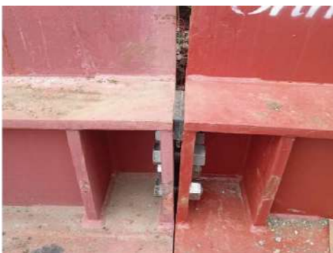
OLY横新型 ジョイント部山折り施工 ☆ジョイント部に硬質プラスチックを挟み緊結☆
