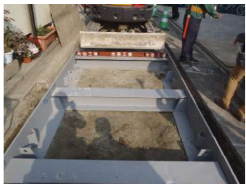
OLY35型 住宅街の狭路 ☆大盛工業 10cm薄型覆工板を使用☆
