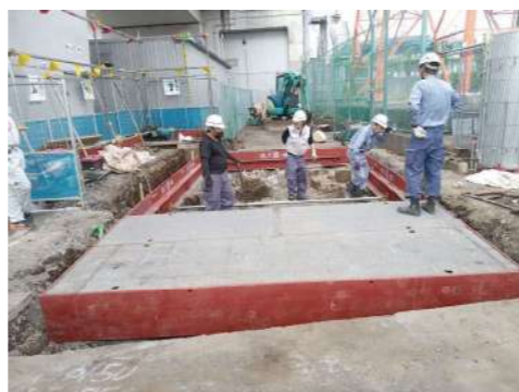
OLY横新型 ジョイント部山折り施工 ☆歩道から車道に向けて緩やかな傾斜☆
