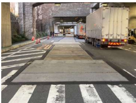
OLY横新型 覆工幅変更 人孔部～管路部 ☆幅変更プレートを使用して、簡単に幅を縮少☆
