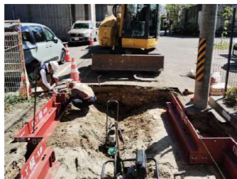
OLY横新型 覆工芯ずらし 電柱回避① ☆幅変更プレートを使用して、電柱回避☆
