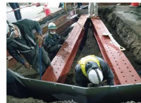
OLY55型 特注製作OLY曲がりプレート施工 ☆既存プレートと特注プレートを簡単に接続出来ます☆
