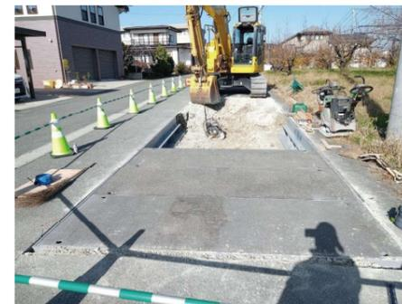
管路160.0m施工の路面覆工を、横型 幅3.0m 延長18.0mを10回転用で施工。
