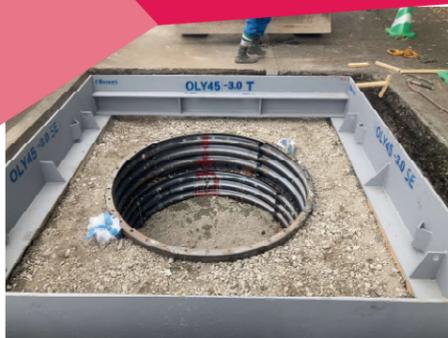
円形ライフプレート2段先行設置後、OLY45型施工
