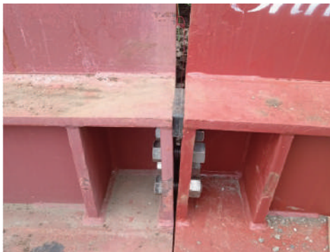
OLY横新型 ジョイント部山折り施工① ☆ジョイント部に硬質プラスチックを挟み緊結☆
