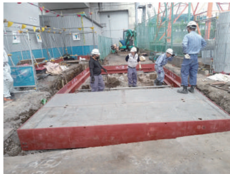
OLY横新型 ジョイント部山折り施工② ☆歩道から車道に向けて緩やかな傾斜☆
