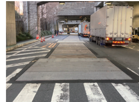
OLY横新型 覆工幅変更 人孔部～管路部 ☆幅変更プレートを使用して、簡単に幅を縮小☆
