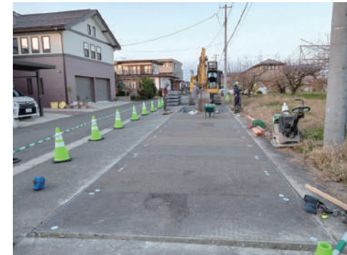
管路160.0m施工の路面覆工を、横型 幅3.0m 延長18.0mを10回転用で施工。 ☆延長の長い路線でも、横型・横新型なら転用もしやすく、コスト削減も見込めます☆
