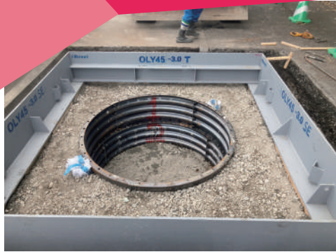
円形リブプレート2段先行設置後、OLY45型施工 ☆OLYならスピーディなので、立坑も同時施工可能☆
