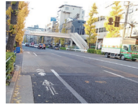
杉並区 青梅街道 都道4号線にて施工 ☆OLY55型 幅5.0m 延長21.0m☆
