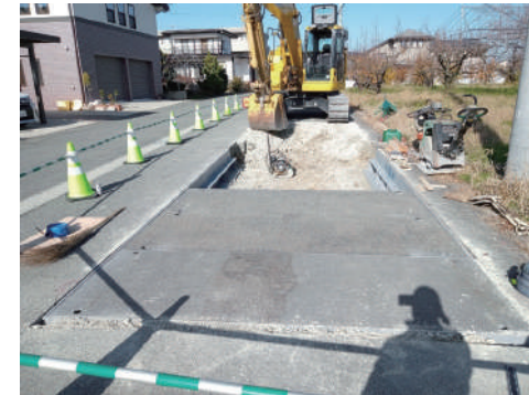
管路160.0m施工の路面覆工を、横型 幅3.0m 延長18.0mを10回転用で施工。 ☆延長の長い路線でも、横型・横新型なら転用もしやすく、コスト削減も見込めます☆
