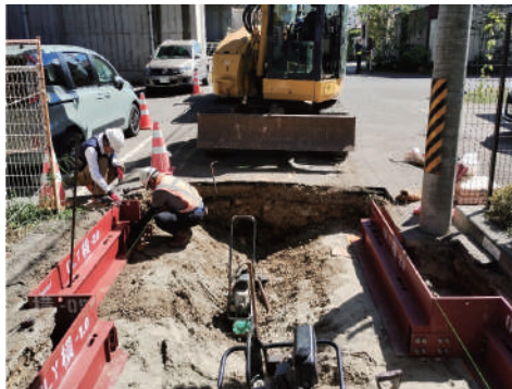
OLY横新型 覆工芯ずらし 電柱回避① ☆幅変更プレートを使用して、電柱回避☆
